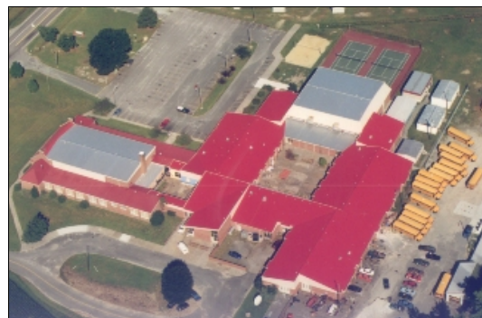
Metalowe pokrycie dachowe, 40-50 lat
