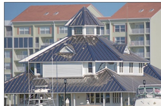
Pokrycie dachowe ze stali nierdzewnej, ponad 50 lat
